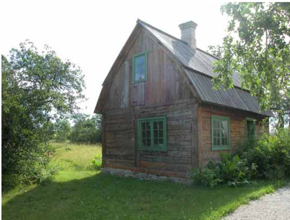
De nordvästra fasaderna innan påbörjat arbete.
