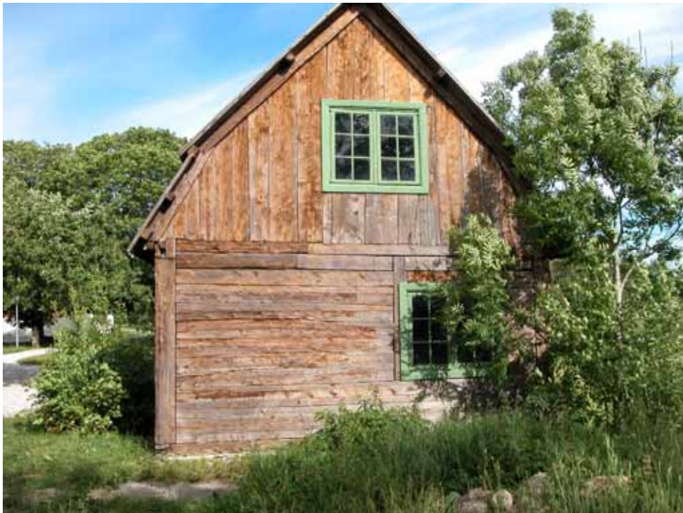
Den södra gaveln innan påbörjat arbete.
