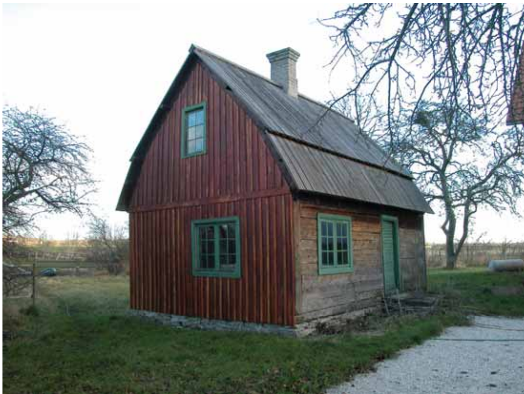
Byggnaden i färdigrestaurerat skick. Foto taget från nordväst.
