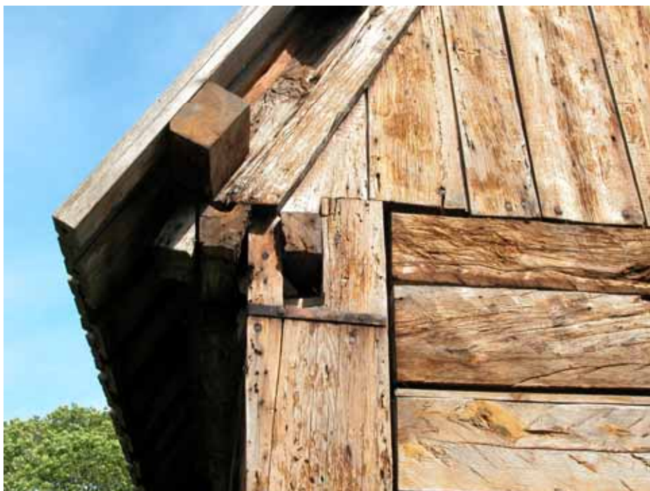
Detalj hornstuck och gaveltakstolen. Gavelspetsens brädor är i uppkant instuckna i en spinning på undersidan av högbenet och festsatta med spik i nedkant
