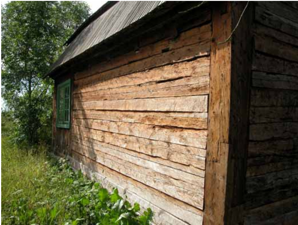
Bakre långsidan innan påbörjat arbete.
