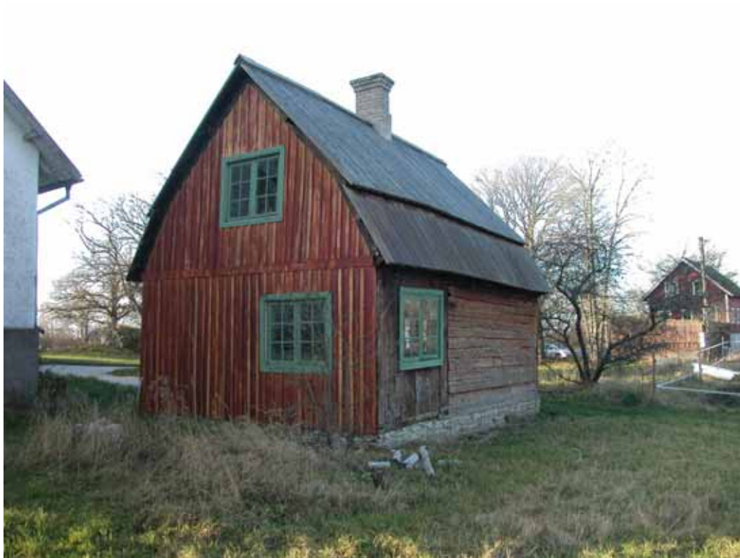
Den sydöstra gaveln i färdigrestaurerat skick.
